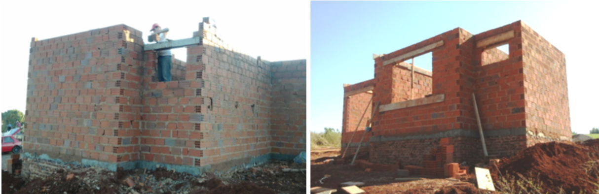
Figura 6. Sequência de fotografias de estágios da elevação da alvenaria da Obra 03.
