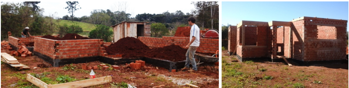
Figura 7. Sequência de fotografias de estágios da elevação da alvenaria da Obra 04.
