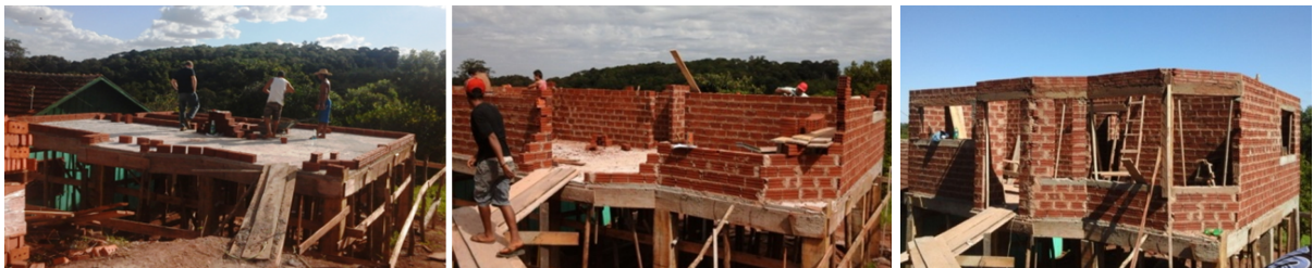
Figura 2. Sequência de fotografias de estágios de marcação/elevação da alvenaria da Obra 01.
