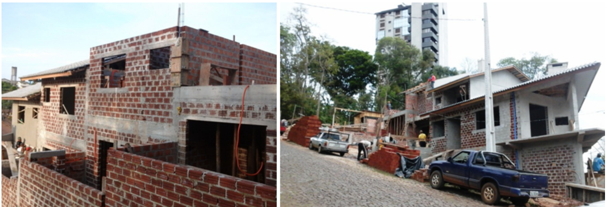
Figura 11. Sequência de fotografias de estágios da elevação da alvenaria da Obra 06.
