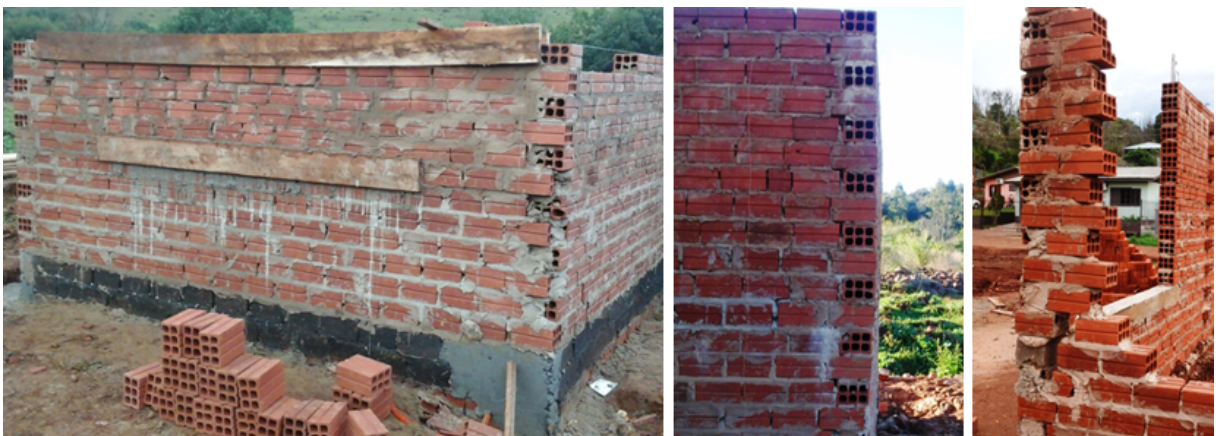
Figura 8. Problemas enfrentados com a mão de obra na execução da alvenaria da Obra 04.
