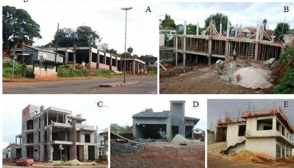
Figura 1. Fotografias das obras visitadas.
