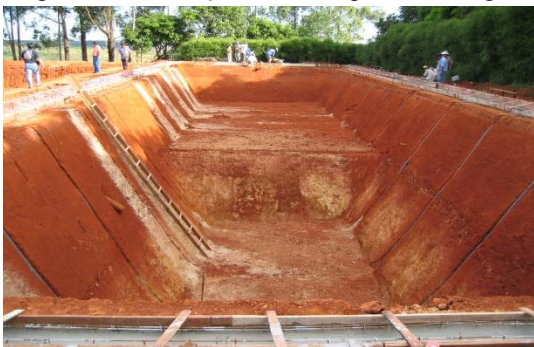
Figura 3 – Escavação de célula para o Biodigestor.
