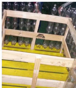
Figura 9: montagem das colunas de litros PET na estrutura do contêiner.
