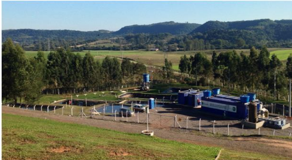
Figura 3: Estação de tratamento do chorume
