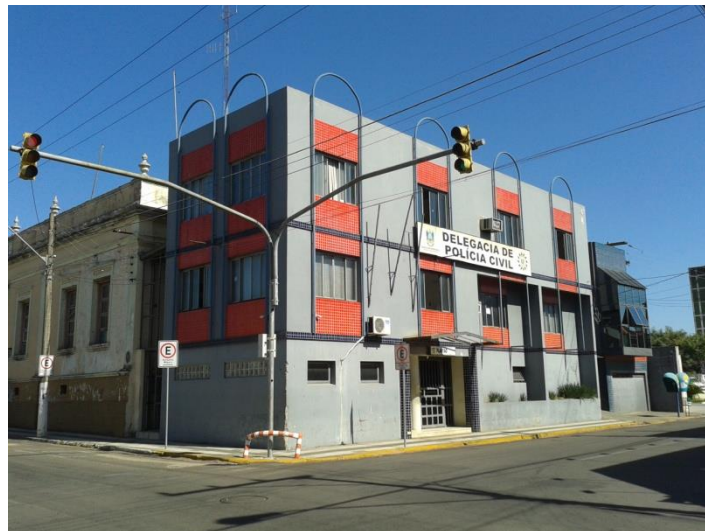
Figura 1 - Vista da fachada frontal e lateral esquerda da Delegacia de Polícia Civil, São Gabriel, RS, Brasil. Fonte: Autor, 2015.
