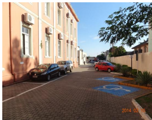
Figura 9 - Vagas para Portadores de Necessidades Especiais no estacionamento da Prefeitura Municipal de São Gabriel, RS, Brasil. Fonte: Autor.
