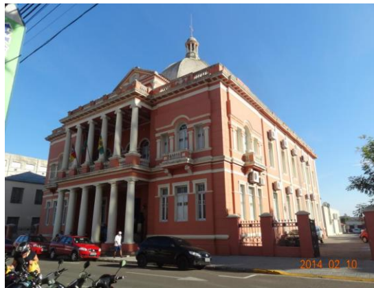
Figura 2 - Vista da fachada frontal e lateral direita do Palácio Plácido de Castro. Fonte: Autor.
