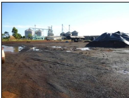
Ilustração 05 – Visão geral do canteiro de uma usina temporária de CAP
