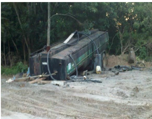
Ilustração 19 – Tanque de armazenamento de CAP Fonte: Registro dos autores
