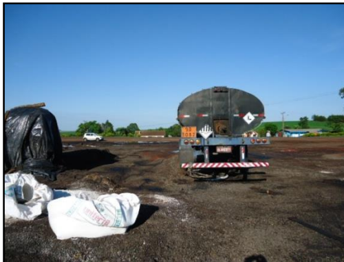
Ilustração 03 – Vazamento de CAP do caminhão-tanque (traseira)
