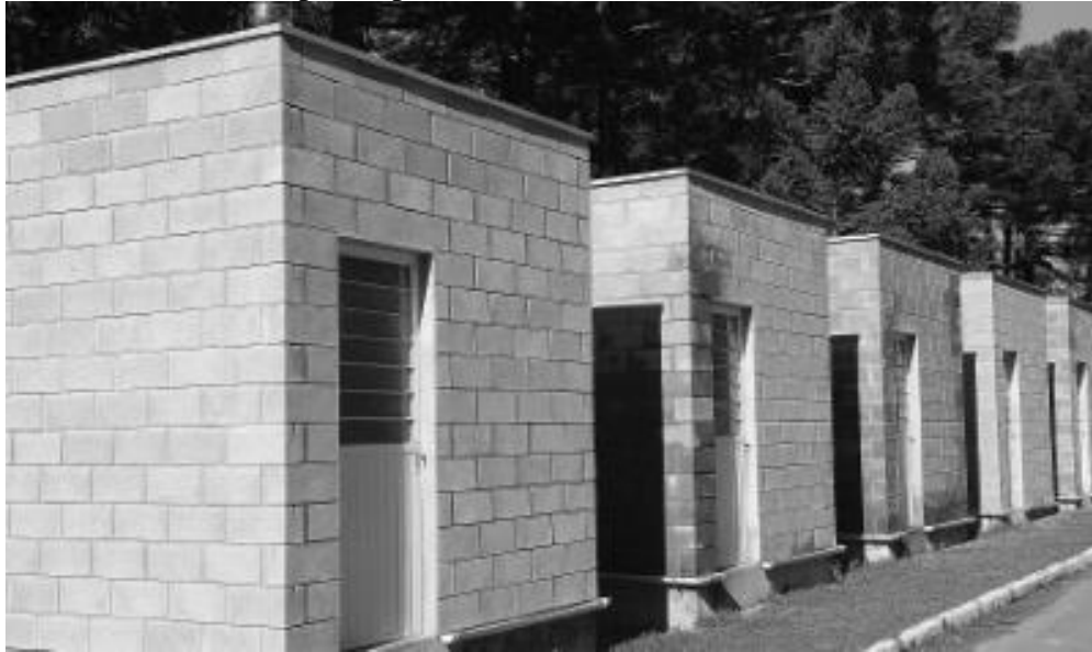
Unidades protótipas, construídas em Caxias do Sul - RS
