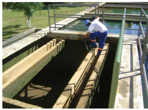
FIGURA 5: Operador da ETA jateando as paredes de um dos filtros (Fonte: O Autor)
