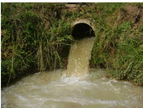
FIGURA 4: Momento do esvaziamento do Decantador (Fonte: O Autor)
