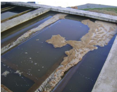
FIGURA 3: Momento em que é iniciada a operação de retrolavagem no filtro (Fonte: O Autor)
