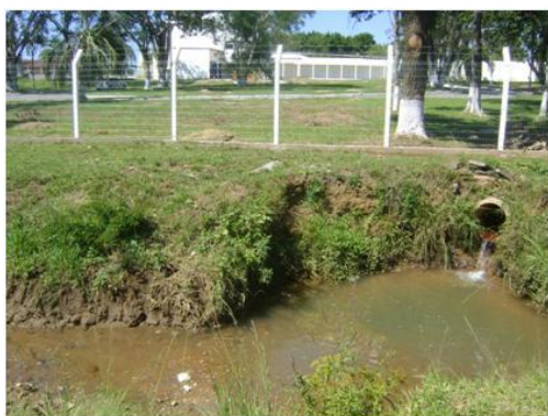
FIGURA 2: Perda frequente de água na ETA (Fonte: O Autor)
